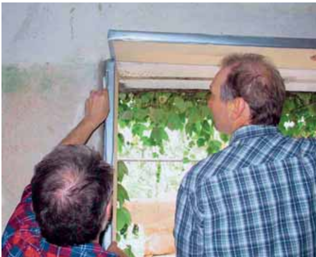
Abb. 6: Zukunftsdämmung mit Anfangsschwierigkeiten: Vakuumisolationspaneele von Variotec.
