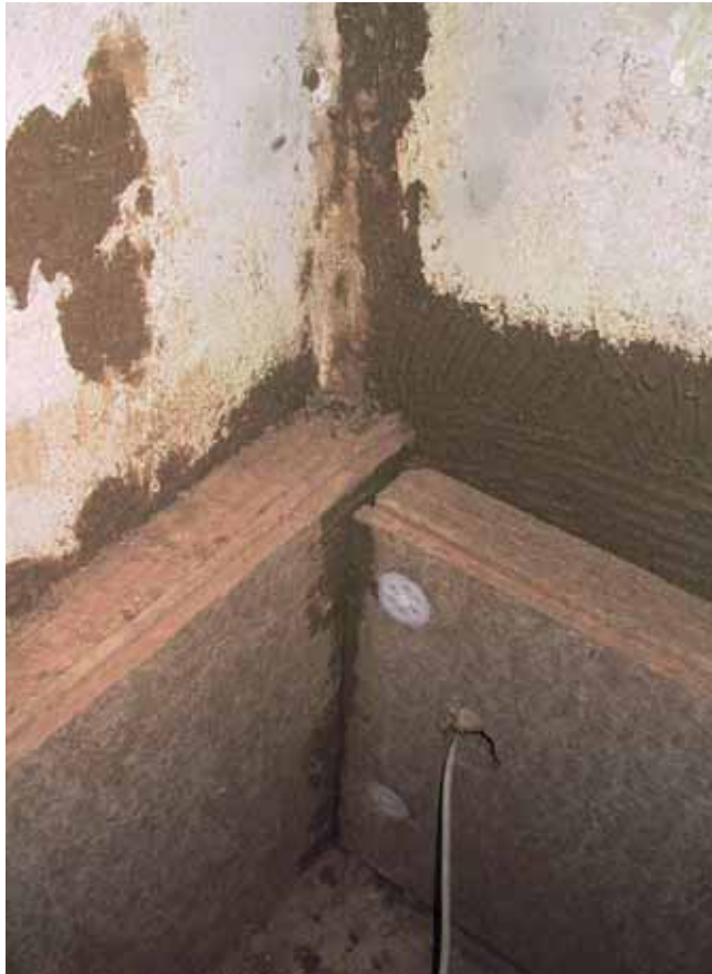
Abb. 2: Innendämmung mit 100 mm Pavadentro-Holzfaserplatten und Lehmmörtel
