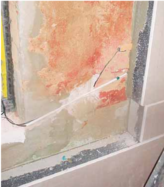
Abb. 5: Relaunch eines alten Systems zur Innendämmung. Die neuen Rigitherm Doublissimo Ver- bundplatten von Rigips.
