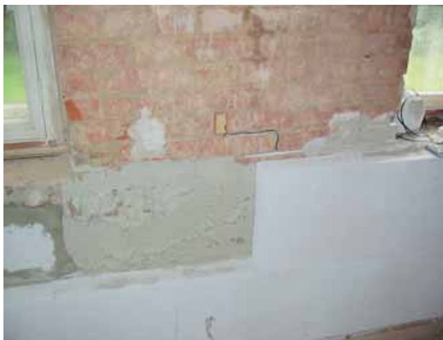
Abb. 3: Innendämmung mit Multipor- Dämmplatten und Verputz auf alter Wand an der vorhandener Putz entfernt werden musste
