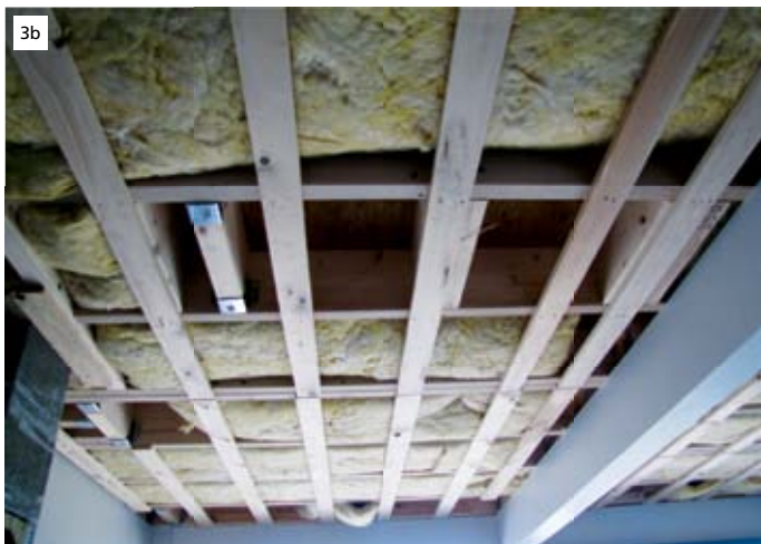
Abb. 3a und 3b: Eine flächige Folie an der Unterseite von Geschossdecken ist in der Regel nicht erforderlich. Notfalls kann die Dämmung auch anders gehalten werden.
