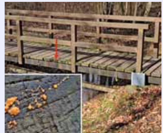
Abb. 10: Braunfäuleschaden an einer Brücke: Doppelbefall mit Gallertränen und Kellerschwamm (das Eckbild zeigt die winzigen, kaum 2 mm großen Fruchtkörper der Gallerträne).
